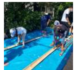
そうめん流し用の土台づくり
